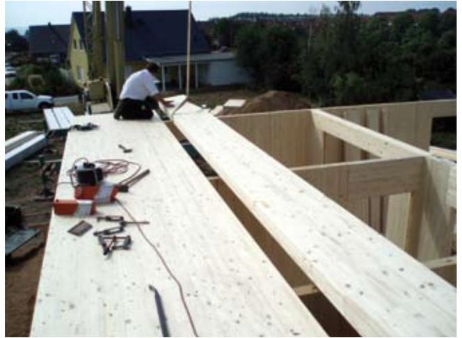
Ausrichten der HBE Deckenelemente
