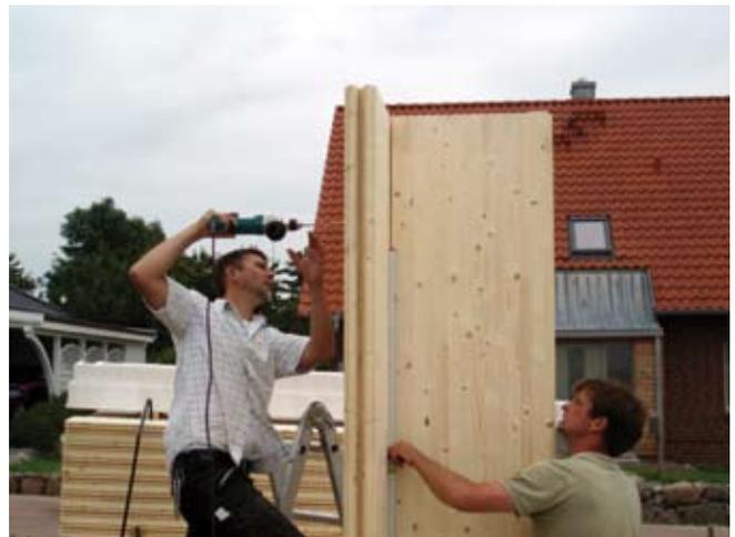
Verschraubung der HBE Wandelemente im Eckbereich
