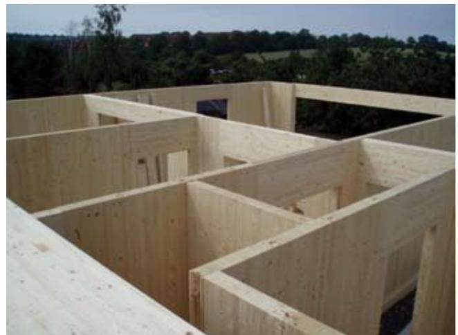
Fertig montierte HBE Wandelemente im EG
