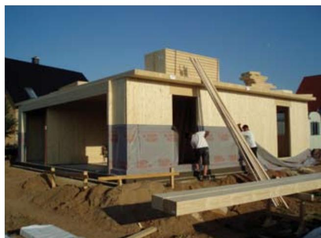
Anbringen der dampfdiffusionsoffenen Luftdichtungsebene gemäß ENEC
