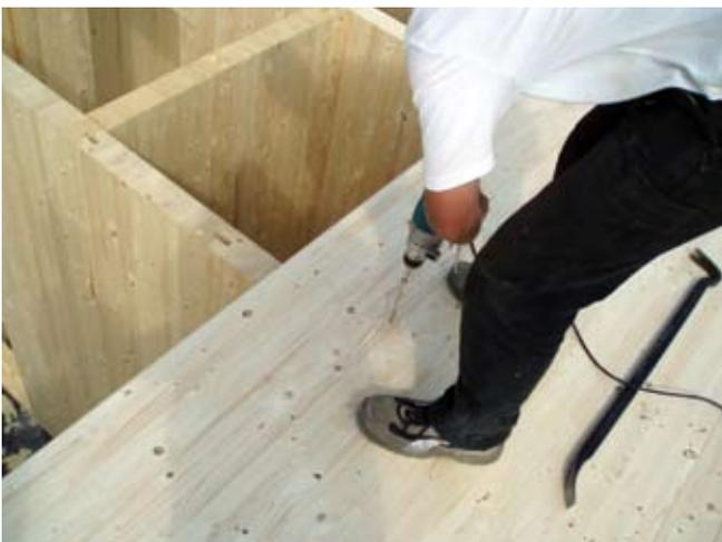
Befestigung der HBE Deckenelemente auf den HBE Wandelementen / Verschraubung
