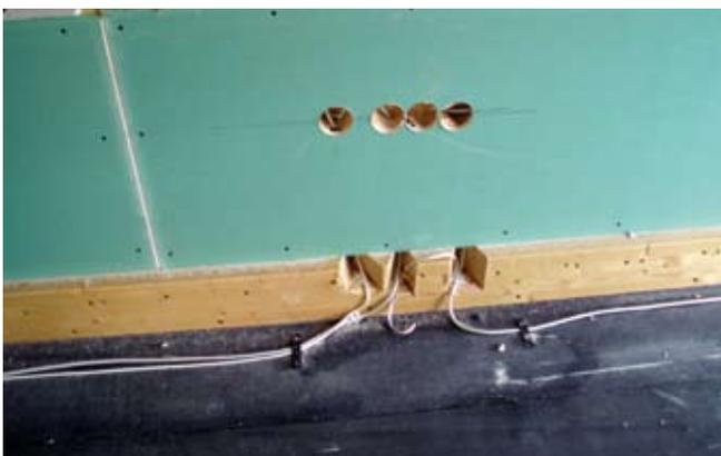
Elektroinstallation / Steckdosen / Ausklüngen mit Kettensäge und Lochsägenaufsatz
