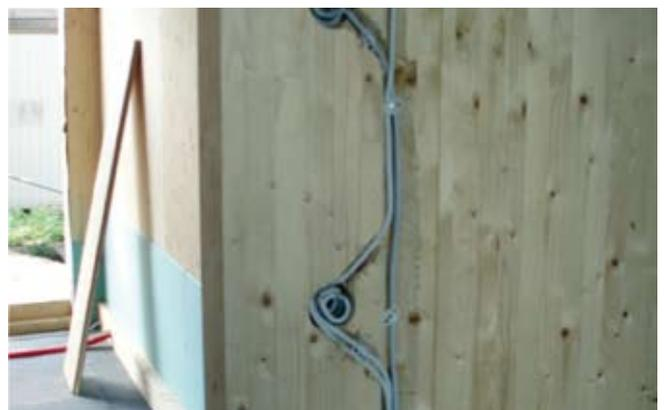
Schlitzen der Kabelkanäle mit der Kettensäge / Elektroinstallation Schalter + Steckdosen
