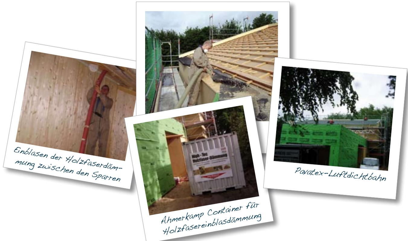
*Einblasen der Holzfaserdämmung zwischen den Sparren*
