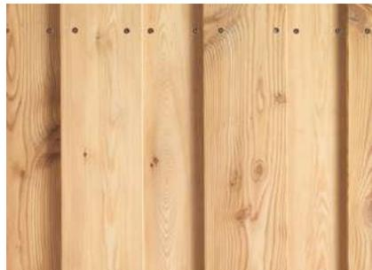
Lärche, Glattkantprofil, gehobelt 20 x 140 mm als Deckel- und Unterprofil
