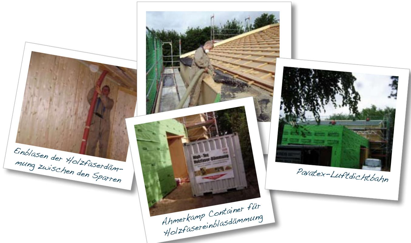
Neben der Einblasdämmung lässt sich STEICOzell auch als Aufblasdämmung verwenden. Das Aufblasverfahren kommt zum Einsatz, wenn STEICOzell als freiliegender Wärmedämmstoff auf horizontalen, gewölbten oder mäßig geneigten Flächen zwischen Bindern oder Balken von Dachstühlen aufgeblasen wird. Egal ob Neubau, Altbau, Fachwerk, Holzbau - oder sonstige Leichtbaukonstruktion – mit STEICOzell lässt sich besonders kostengünstig und ökologisch dämmen.
