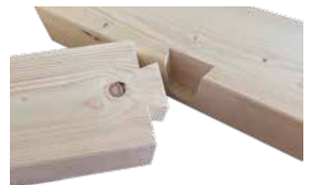
Schwalbenschwanz-Verbindung mit Zulassung
